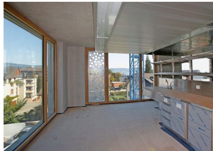
Im Erdgeschoss des Anbaus wird eine neue Küche realisiert. Foto: Sabine Rock
