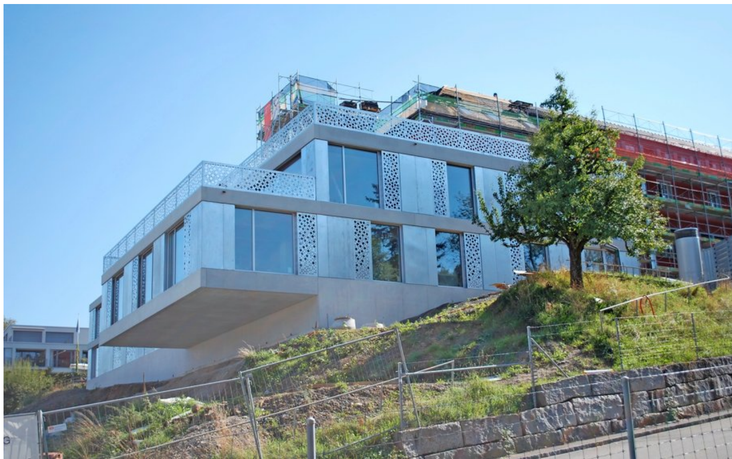
Sichtbeton, Metall und Glas sind die Materialien, die für den Anbau des Pflegezentrums Fuhr verwendet wurden.
